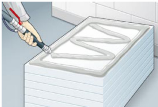
8 att. Līmjavas uzklāšana uz siltumizolācijas loksnēm mehanizēti [1]
